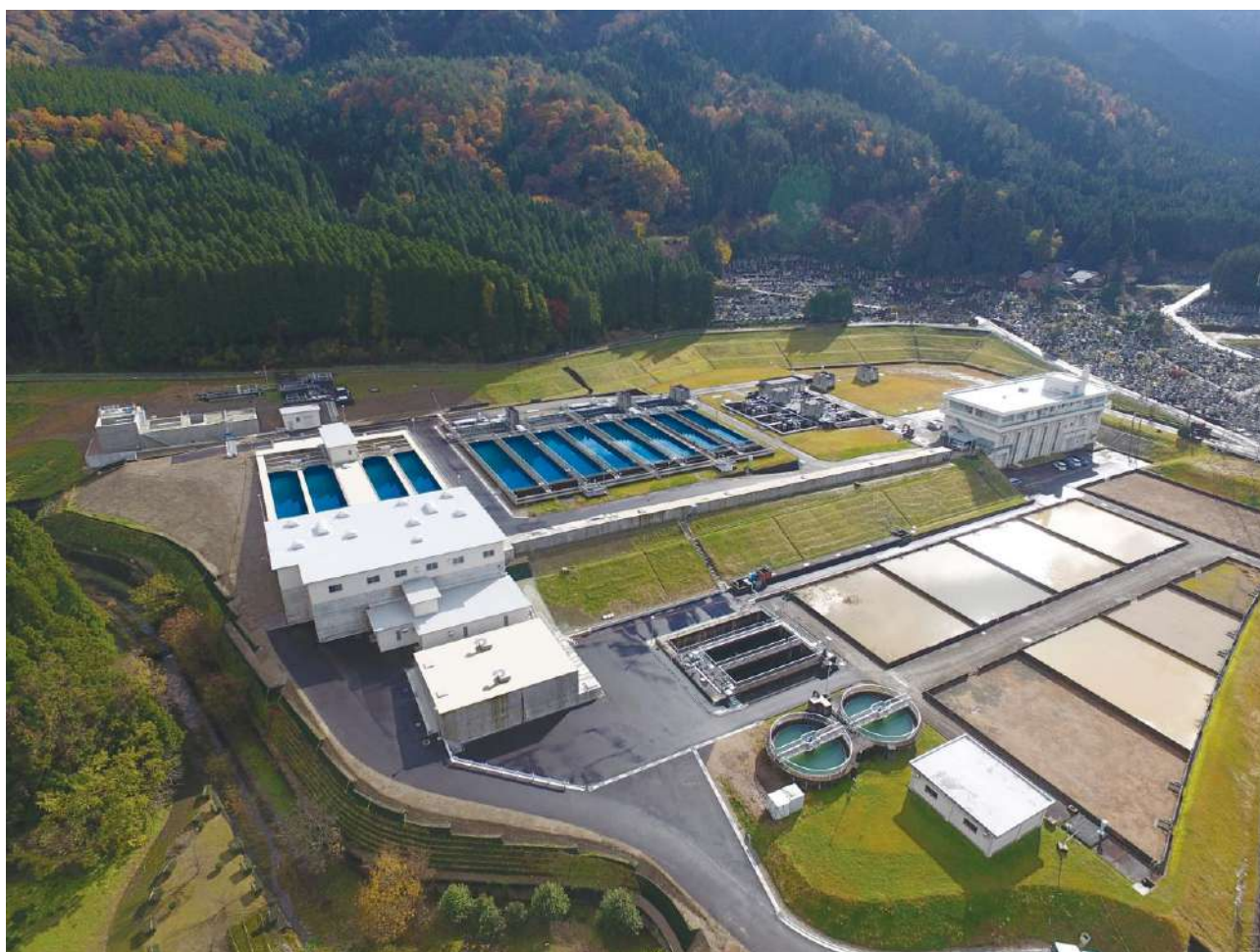
松島浄水場（南砺市）
